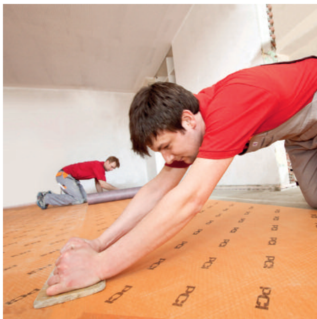
PCI Pecilastic U einlegen und fest andrücken, z. B. mit einem Holzbrett oder Hartgummi-Fugbrett.
