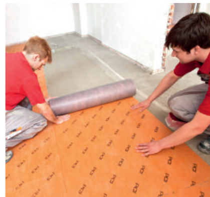
Keramische Beläge können auf der Abdichtungs- und Entkopplungsbahn PCI Pecilastic U funktions sicher verlegt werden.
