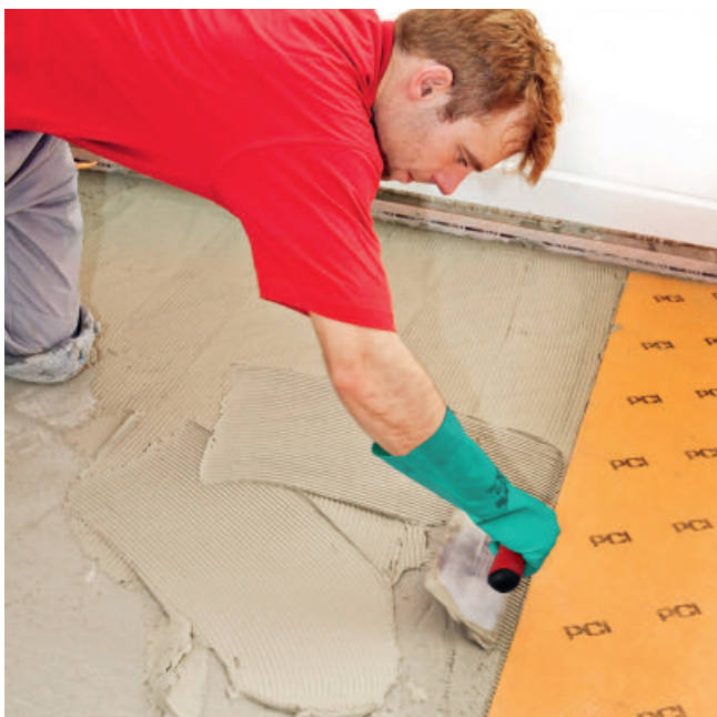
Auf dem vorbereiteten Untergrund PCI Flexmörtel S1 Flott aufkämmen...
