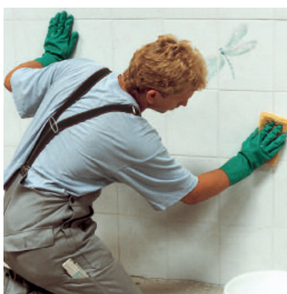
Den verbliebenen Mörtelschleier mit einem feuchten Schwamm entfernen.
