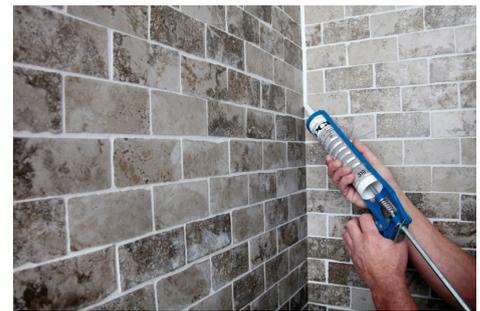
Durch den Einsatz von PCI Carraferm entstehen keine Randzonenverfärbungen bei Naturwerksteinen.
