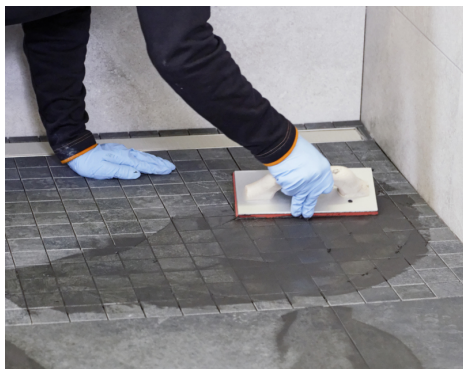
Sehr leichtes Verfugen ohne Restschleier mit PCI Durapox Premium.
