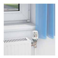
**falsch**Der Thermostat-Kopf mit eingebautem Fühler darf nicht senkrecht montiert werden.
